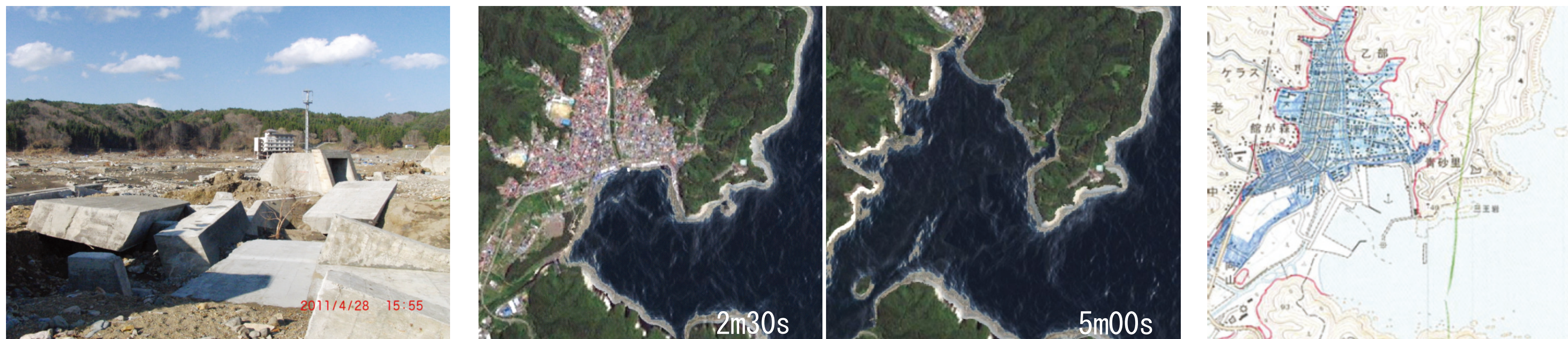
田老地区の被災状況(左), 津波遡上計算(中), 津波遡上実測データ(右)
