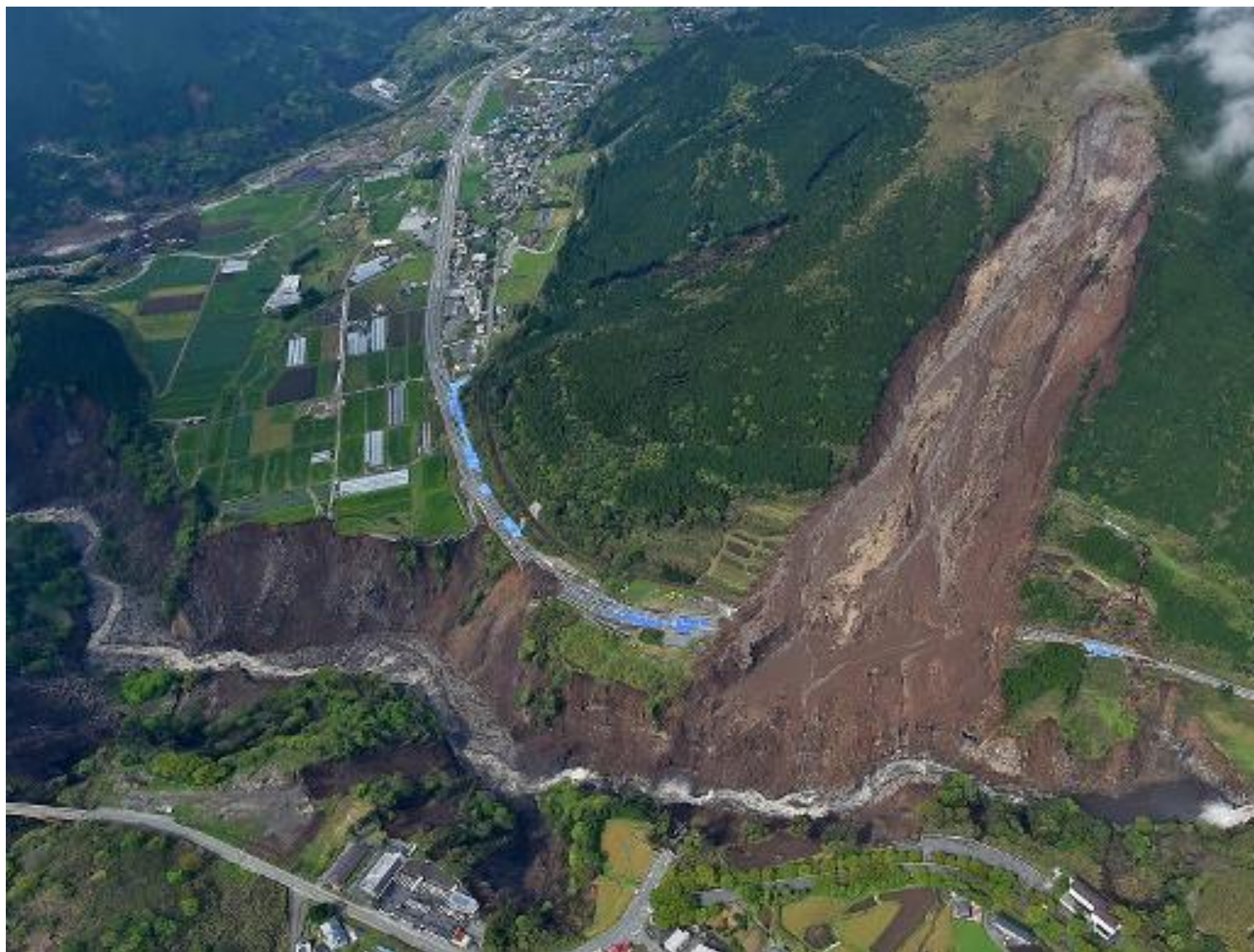
2016年阿蘇の斜面崩壊（熊本地震）
