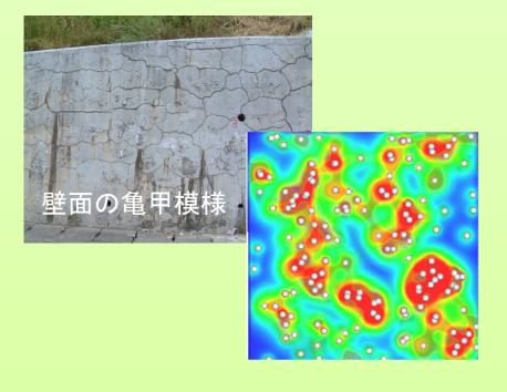
アルカリシリカ反応(ASR)による骨材膨張と、骨材膨張に伴うひび割れをモデル化する. ASRはアルカリイオンの非定常拡散解析、ひび割れは損傷モデルを導入した非線形有限要素解析によって行い、これらを分離型時差解法によって連成している. 左図に示すようなコンクリート壁の亀甲を表現するために、数千万ボクセル規模の解析を予定している.
